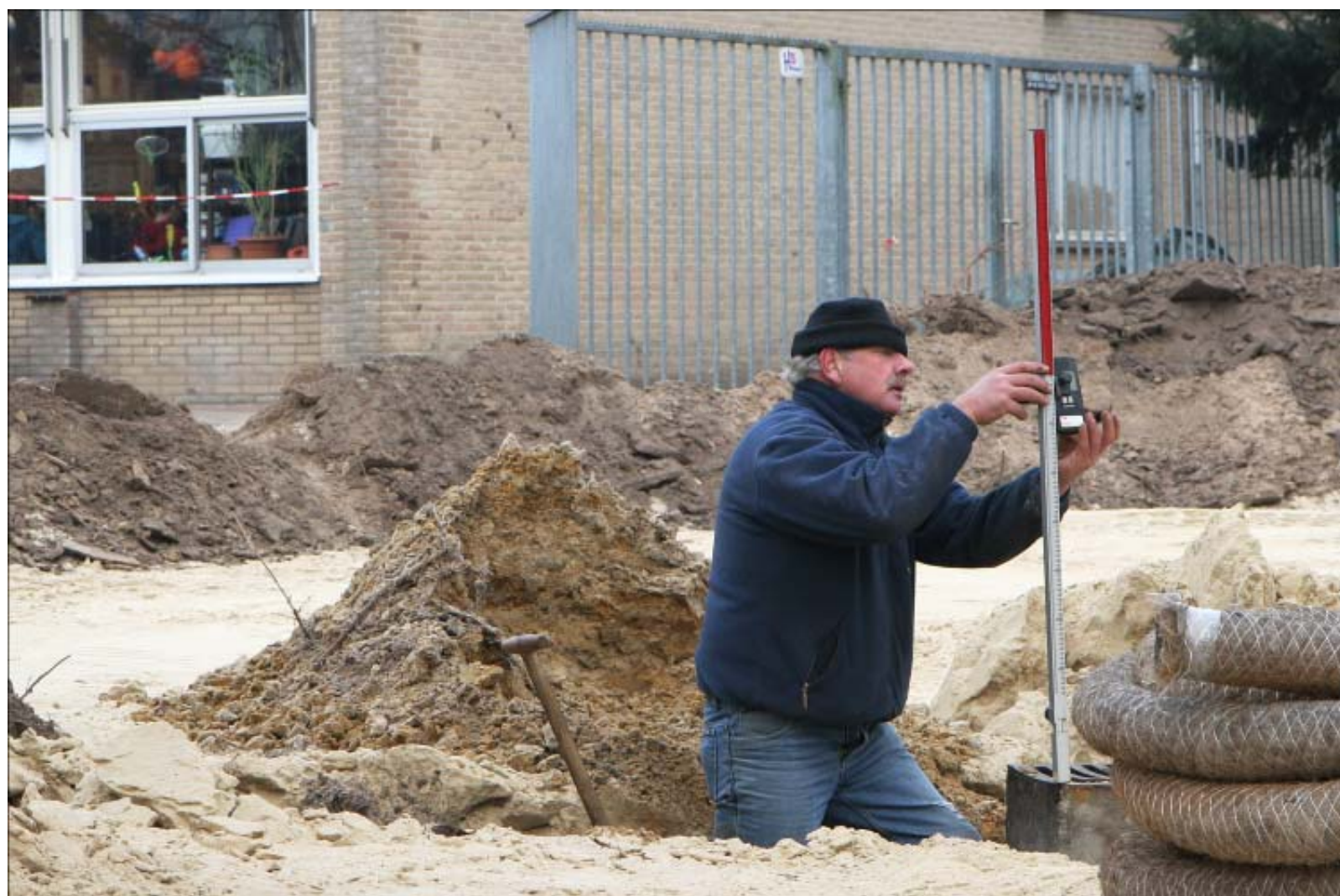
Het terrein naast de Elzenhof wordt bouwrijp gemaakt voor de komst van tien starterswoningen.
