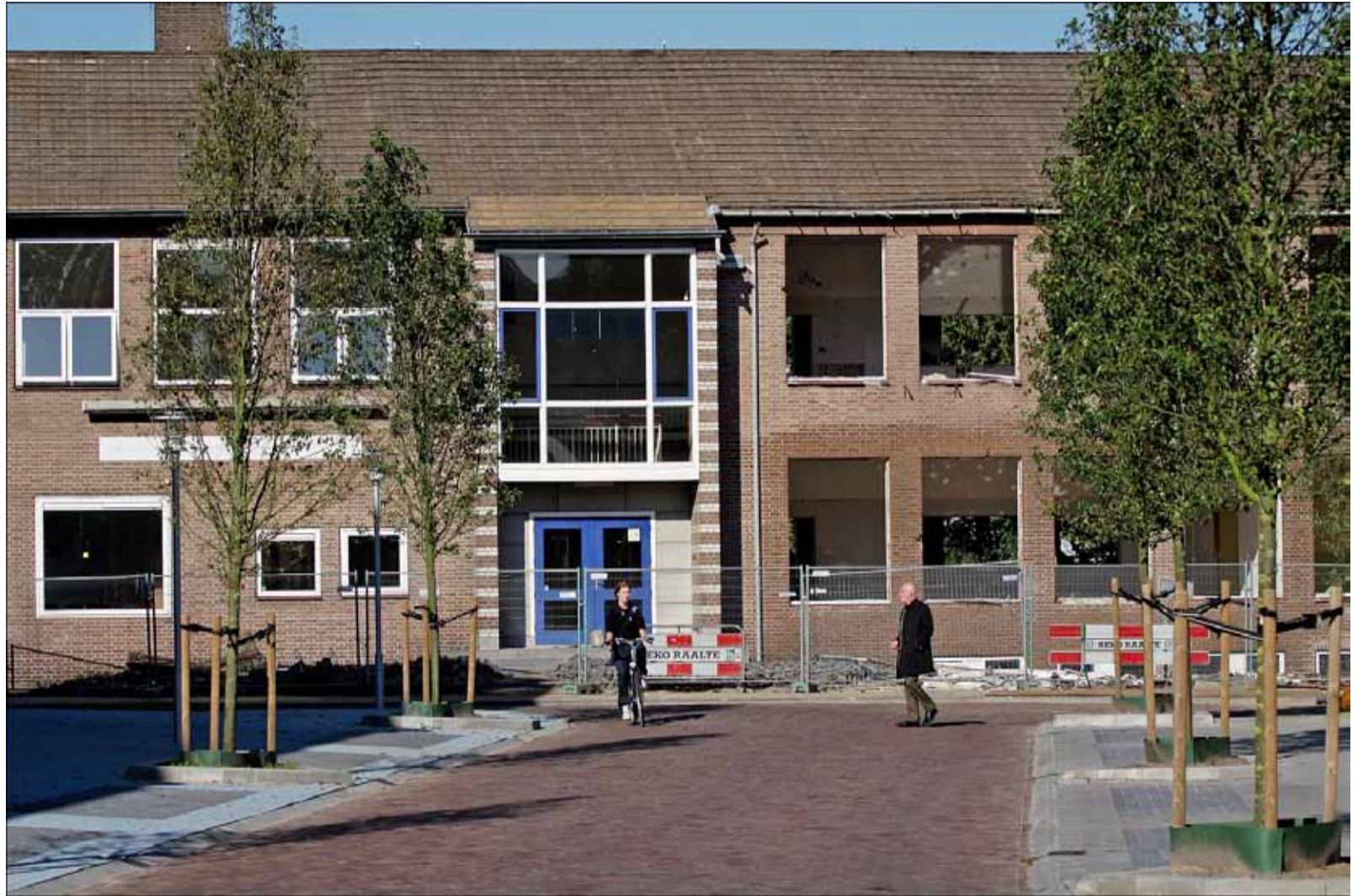
Onder de inmiddels afgebroken Clara Feyoenschool aan de Marslaan is verontreiniging aangetroffen.
