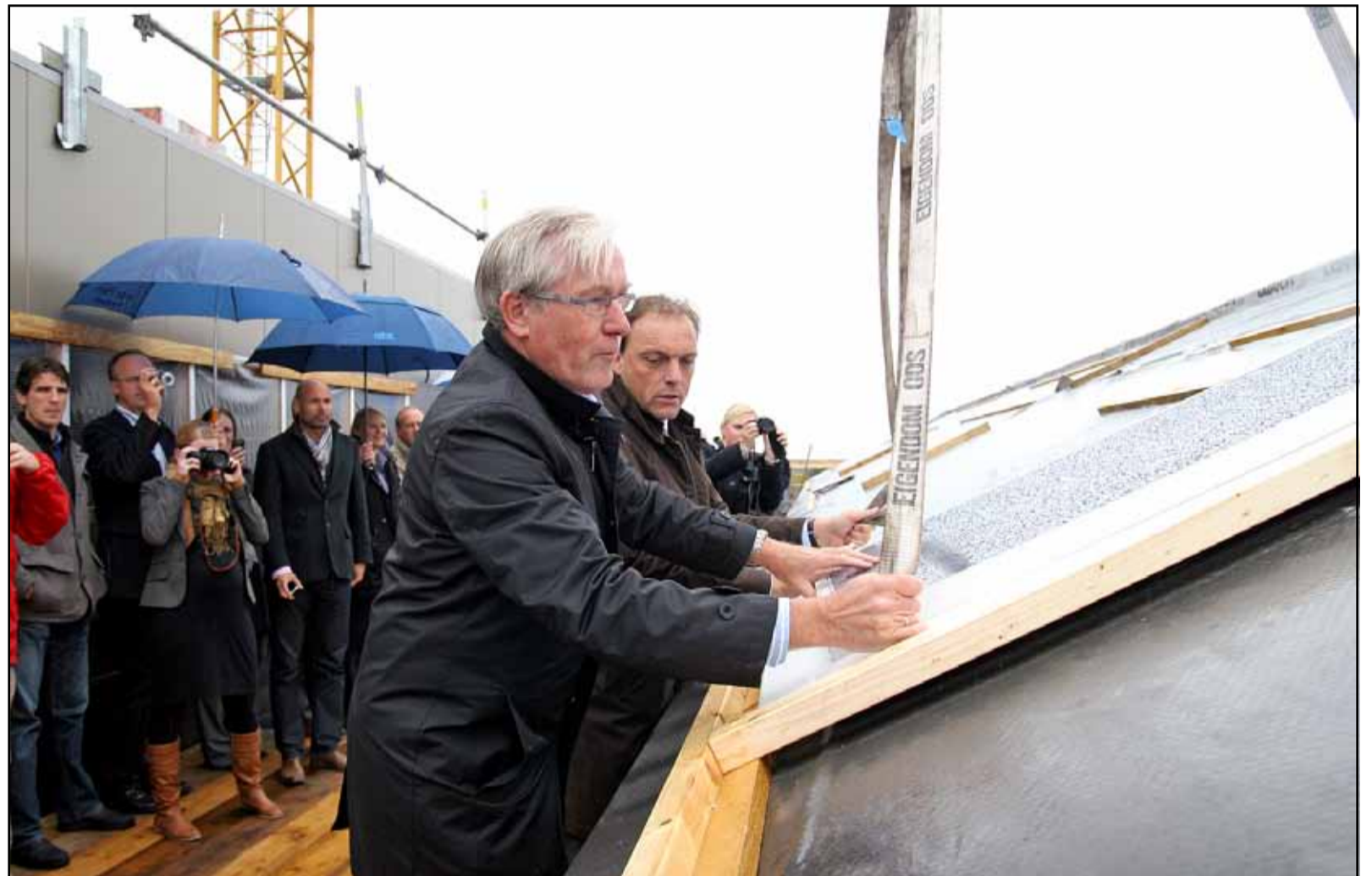
Ter gelegenheid van het bereiken van het hoogste punt wordt een zonnepaneel geplaatst.
