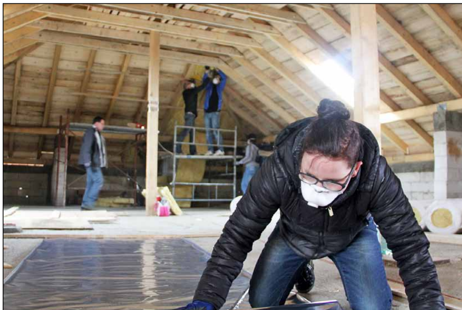
Het team uit Hardenberg heeft in de school in Siret onder meer dakisolatie aangebracht.
