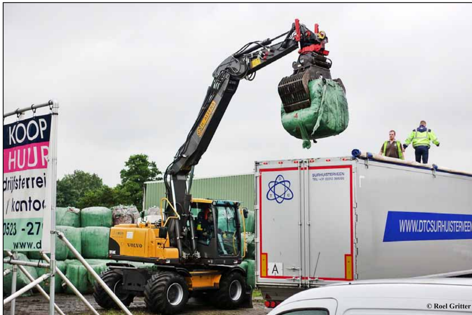
Nadat het afval op industrieterrein De Nieuwe Haven in Hardenberg was verwijderd is een juridische strijd losgebarsten.
