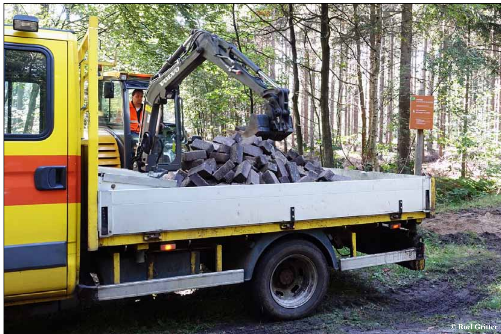
Als eerste zijn de stroken met klinkers opgeruimd, die tussen het asfalt lagen.
