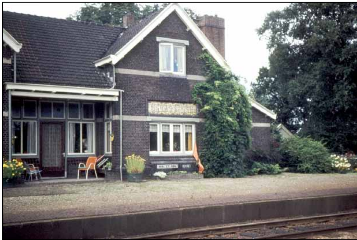
Station Bergentheim zoals dat tot 1975 in gebruik was. In 1993 is het gesloopt.
